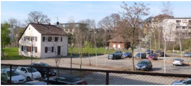
Das Wasserwerksgelände an der Werastraße vor Baubeginn. Im Hintergrund...
